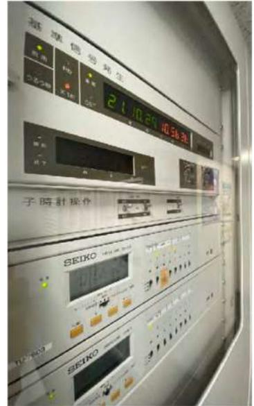
和光の時計塔は放送局レベルの設備時計（うるう秒にも対応しており、数年に1回程度の調整）。
